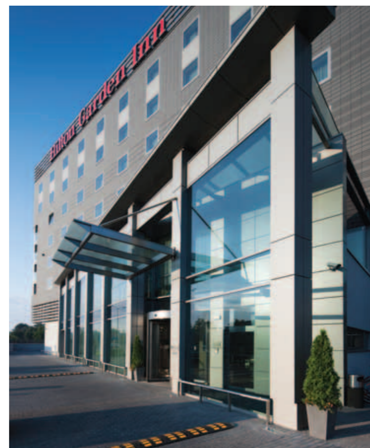
SYSTEMY KLIMATYZACJI Z ODZYSKIEM CIEPŁA PRACUJĄCE DLA HOTELU HILTON GARDEN INN W KRAKOWIE
